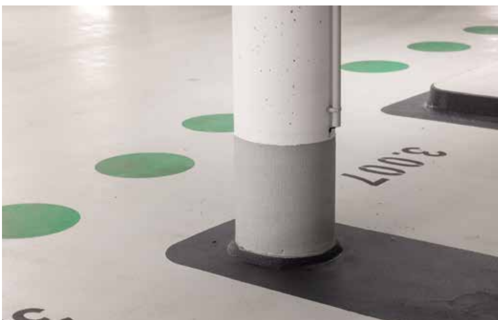
Nach der Sanierung: Die Standsicherheit des Pfeilers ist dauerhaft wiederhergestellt.
