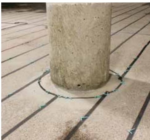
Bei der Sanierung kam das Verfahren des Kathodischen Korrosionsschutzes zur Anwendung – im Bild die Einbettung der Bandanoden in den Boden.
