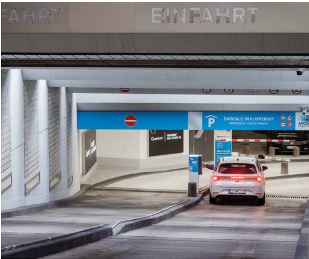
Die zentral in Köln gelegene Tiefgarage „Im Klapperhof“ wurde umfangreich saniert und erstrahlt nun im neuen Glanz.
